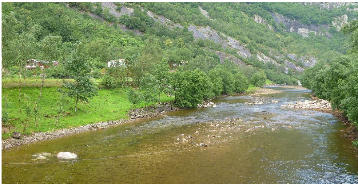
Eksempel på tiltak for å skape økt morfologisk variasjon på en utrettet elvestreking ved utgraving, steinutlegg og buner. Eksemplet er hentet fra Frafjordelva i Rogaland (Foto: Ulrich Pulg).
