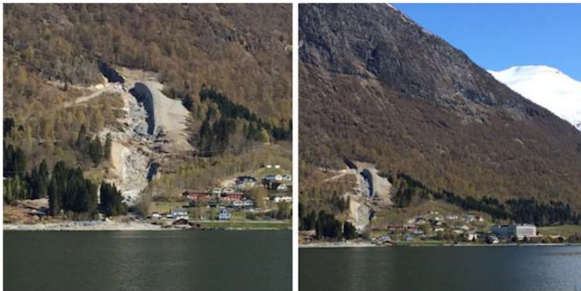
Sikringsanlegget i Gjølmunna i Stryn kommune ble ferdig i november 2015 og sikrer boliger og hotell mot framtidige ras.
