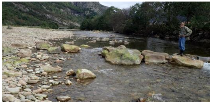
Steinutlegg i Frafjordelva (Espen O. Espedal)
